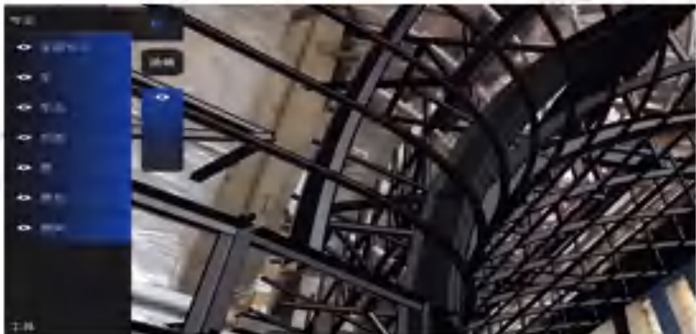
图 3.2-14 AR 钢结构安装复核
