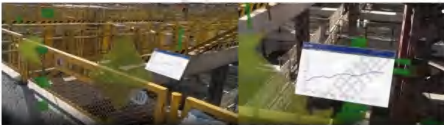
图 3.2-16 基于混合现实技术的基坑监测风险巡视场景图
